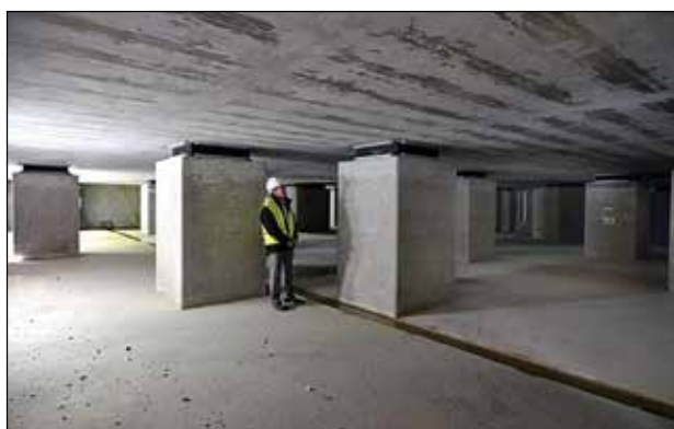
Obr. 13: Prostor seismických izolátorů pod základovou deskou
