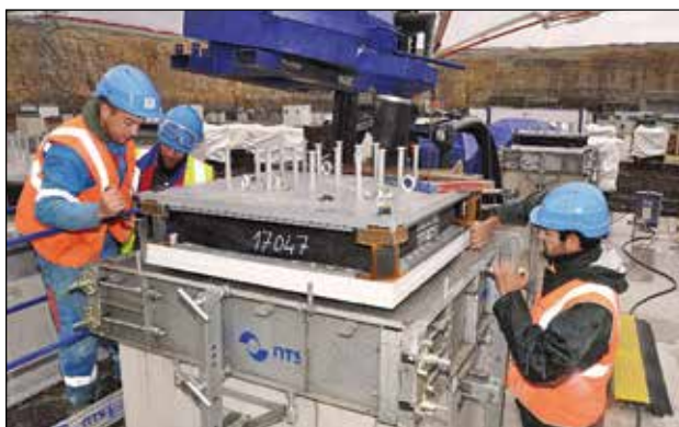
Obr. 6: Montáž tlumiče na betonový podstavec
