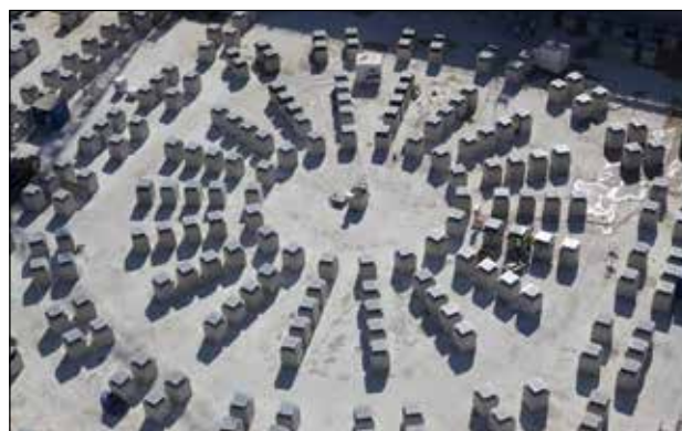
Obr. 8: Rozmístění izolátorů pod reaktorem
