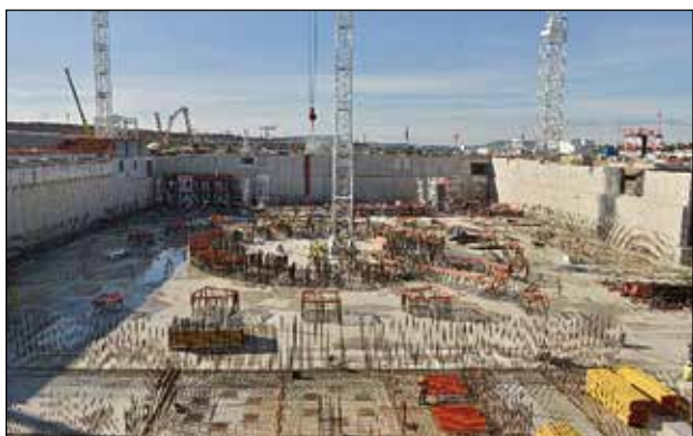
Obr. 12: Ukončená základová deska
