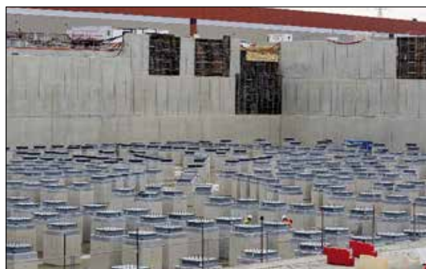
Obr. 7: Dokončené seismické izolátory
